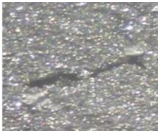
Рис. 1. Деструкция полимерной матрицы с газовыми полостями и трещинами.
